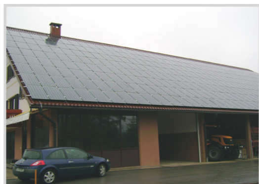
Sončna elektrarna Košir 67 kW, Polhov Gradec
