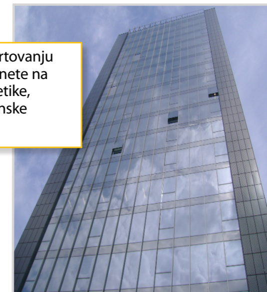
Sončna elektrarna, integrirana v levi in desni rob fasade 100 kW, BTC Ljubljana
