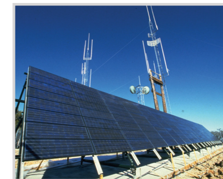
Sončna elektrarna, ki napaja telekomunikacijsko postajo
