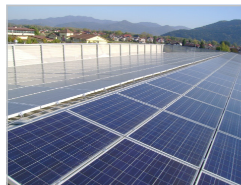
Sončna elektrarna Fortuna 240 kW na strehi zgradbe, Vrhnika
